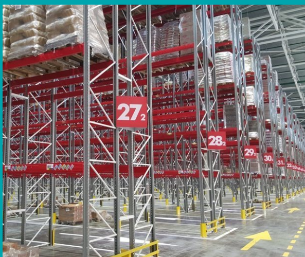
г. Москва, фронтальные стеллажи, склад на 29 000 п. м.
